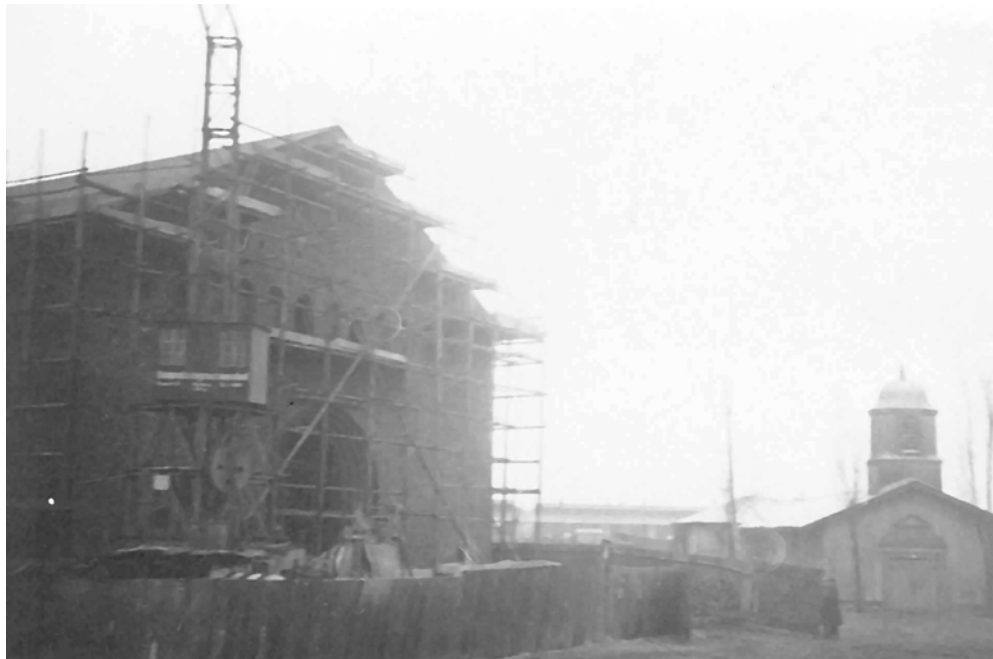
Die 1935 fertiggestellte Kunigundenkirche 1934 im Rohbau. Im Hintergrund ist die vorläufige Behelfskirche zu sehen. Im Jahr 1922 wurde St. Kunigund eine eigenständige Pfarrei, vorher war sie eine Kuratie, der Pfarrei Herz Jesu.
