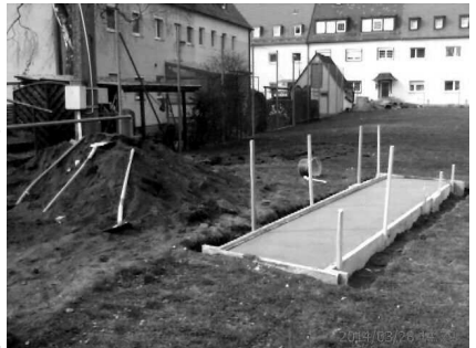
Das neue Fundament für die Trainerbänke
